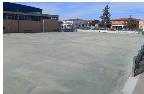
Hormigonado del patio y pintado de la vaya exterior del Colegio Cervantes.
