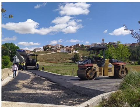
Asfaltado Calle del Río, caminos de la Ermita y Castillo y Calle de las Cooperativas.
