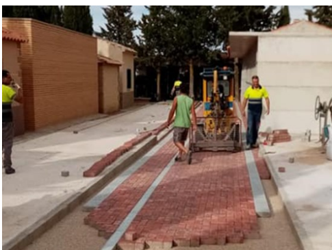
Ampliación de nichos y paseos en el cementerio municipal.
