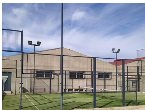
Inicio de las obras de dos nuevas pistas de pádel en el complejo deportivo junto a la piscina.
