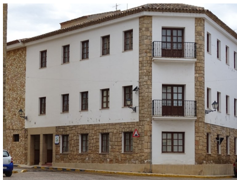
Dotación presupuestos 2023 Consejería Sanidad: 667.370 € para la remodelación del centro de salud.
