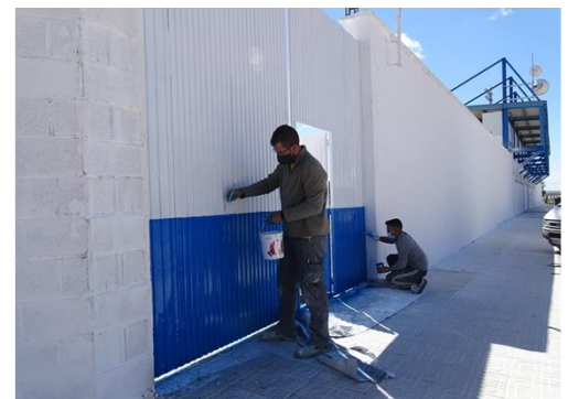
Obras de mantenimiento y nuevos aseos en el campo de fútbol municipal.
