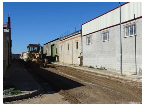
POS - Asfaltado de calles en el Polígono Ganadero de Munera.
