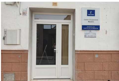
Obras de rehabilitación y accesibilidad del Centro Ocupacional de discapacitados.
