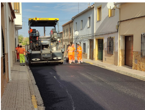
POS - Asfaltado de calles en mal estado en el casco urbano.
