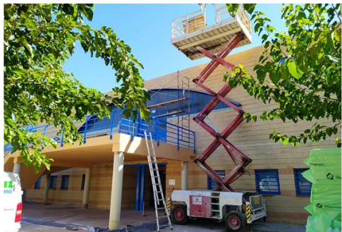
Obras reparación e impermeabilización del techo del pabellón polideportivo.
